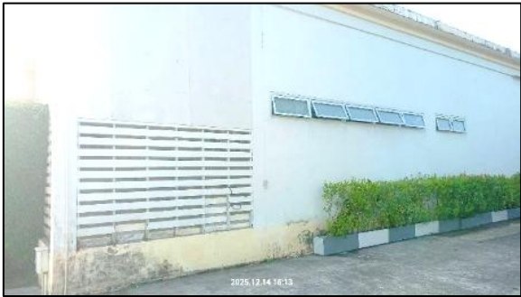
ช่องเปิดระบายอากาศและระบายความร้อนในอาคาร
