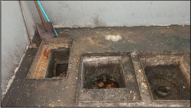
จัดให้มีเจ้าหน้าที่คอยตัดไขมันออกจากบ่อดักไขมันทุกวัน
